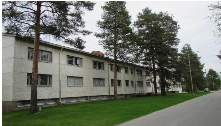
Kuva 59: Kasarmialueen maisema- ja kaupunkikuvalle ovat leimallisia pitkät, horisontaaliset rakennusmassat ja näiden vastapainona vertikaaliset, jylhät männiköt sekä erilaiset aukiot.
