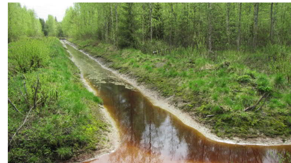
Kuva 51: Uutta suoralinjaista ojitusta alueen eteläosassa. Maasto on rakennettua ympäristöä ja muutamia kuivahkoja kankaita lukuun ottamatta luontaisesti melko kostea.
